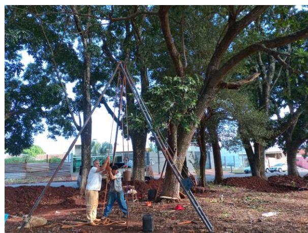
Figura 5 – Execução do furo 2
